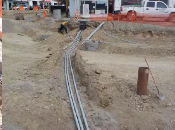
Conduit installation
